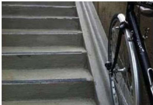
Figura 104: Esempio di canalina per ciclisti e di caditoia in favore della mobilità ciclistica
