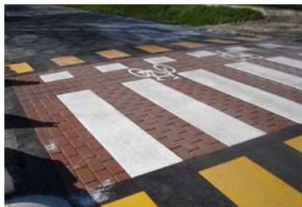
Figura 105: Esempio di trattamento di irruvidimento superficiale e di attraversamento in asfalto stampato
