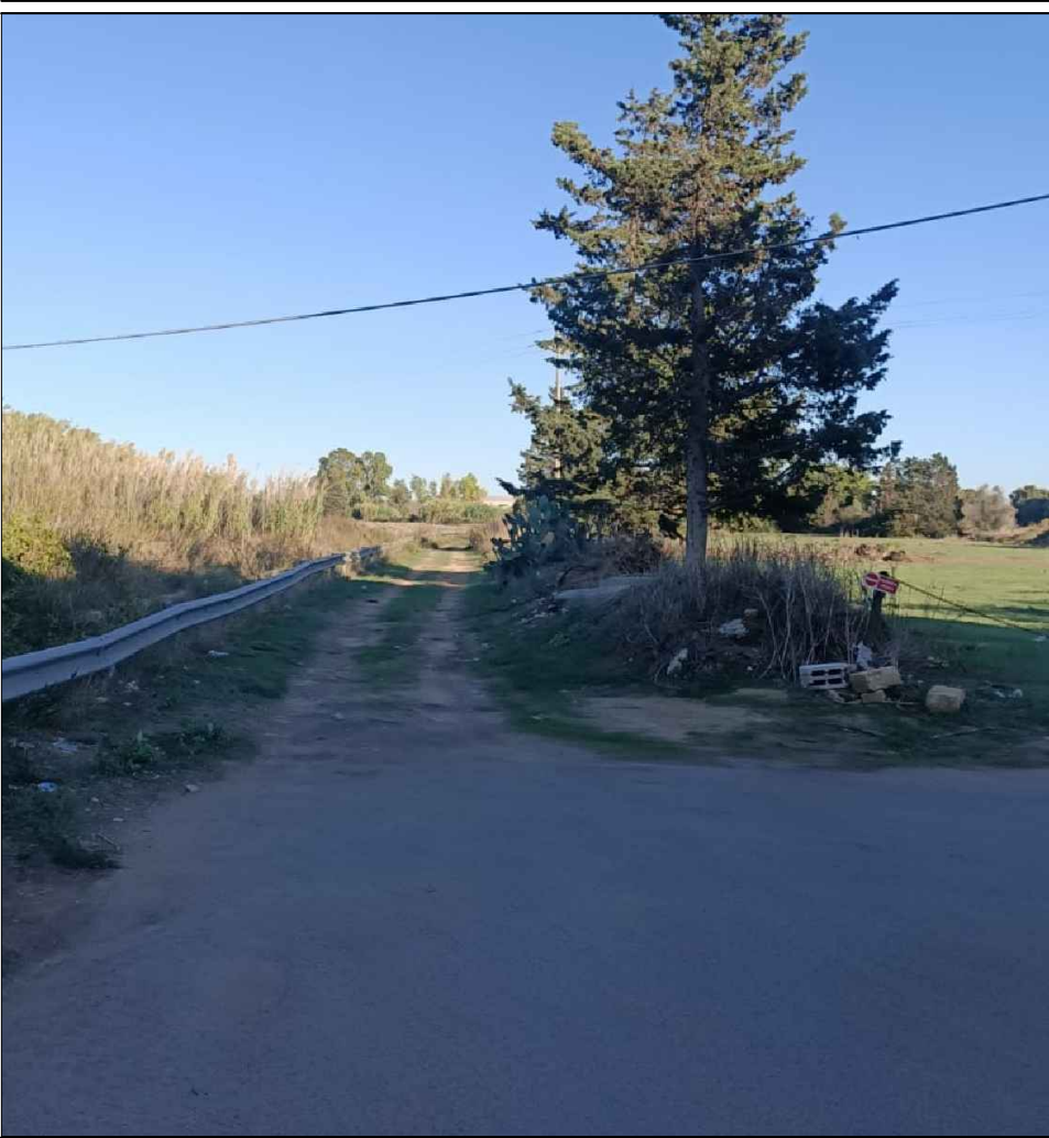
Ripresa fotografica n.1: Deviazione da S.P.198
