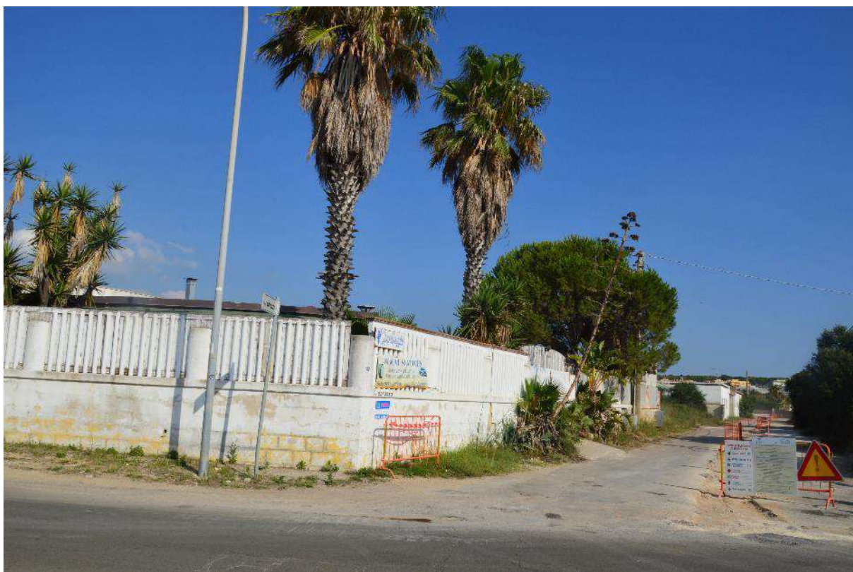
Figura 3-18 – inizio dei lavori relativi alla realizzazione della condotta AQP nel sito di progetto.
