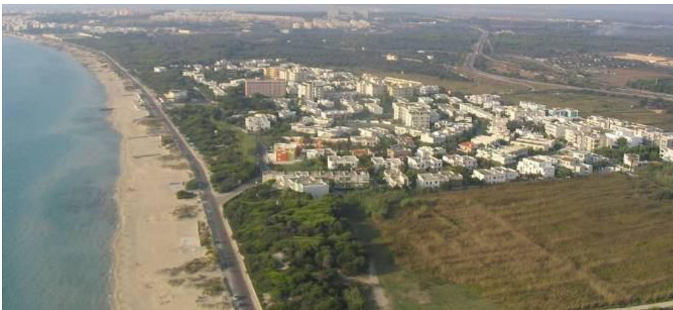
Piattaforma turistico-residenziale (Baia Verde) e strada litoranea realizzate a ridosso del cordone dunale.
