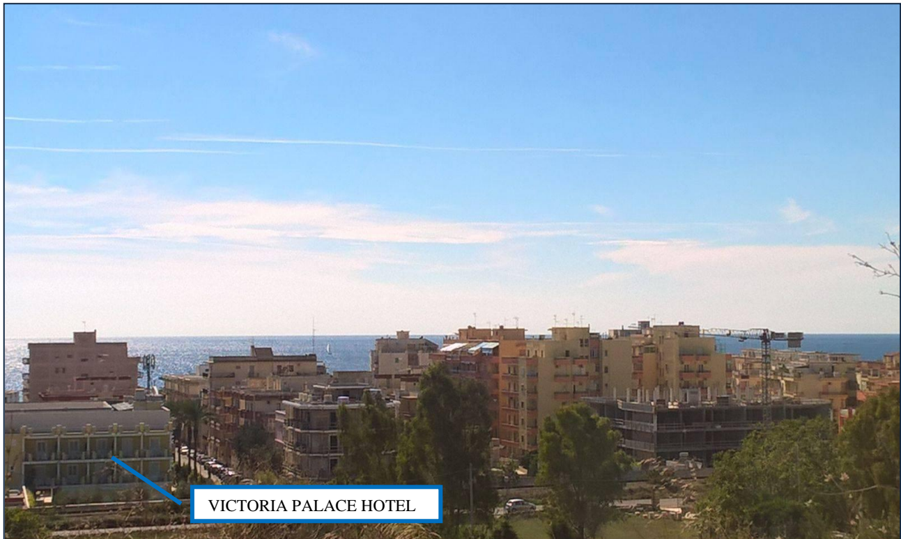
Vista fotografica del Victoria Palace Hotel in rapporto al tessuto edificato circostante
