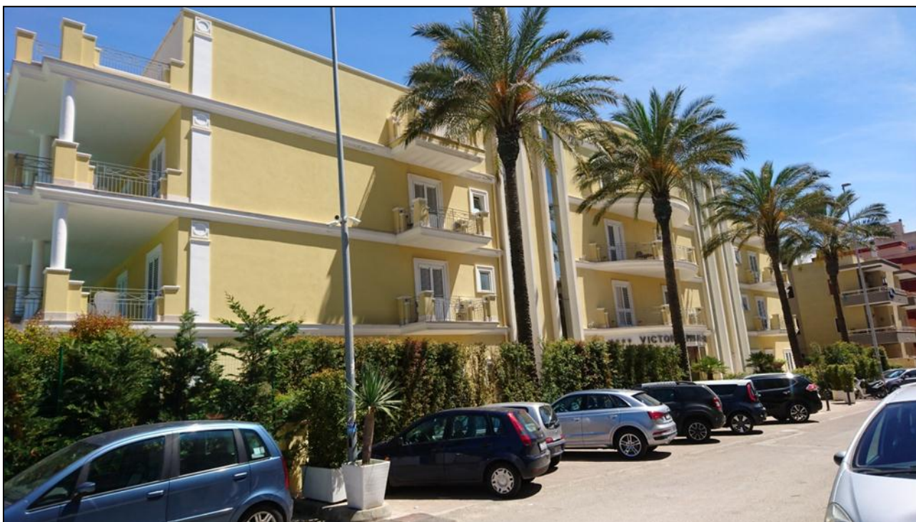
Vista fotografica esterna del Victoria Palace Hotel – stato di fatto
