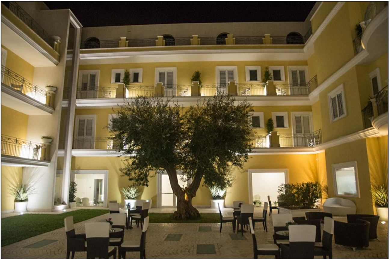
Vista fotografica della corte interna del Victoria Palace Hotel – stato di fatto
