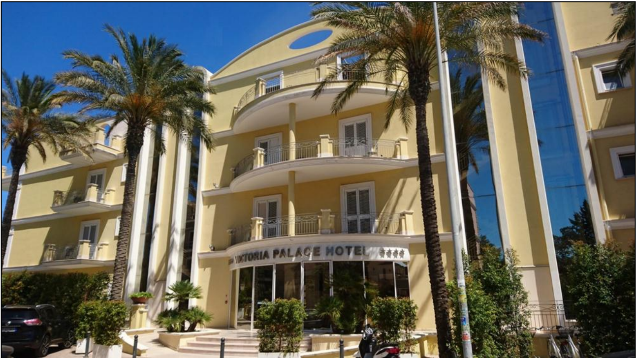
Vista fotografica del prospetto ovest del Victoria Palace Hotel – stato di fatto
