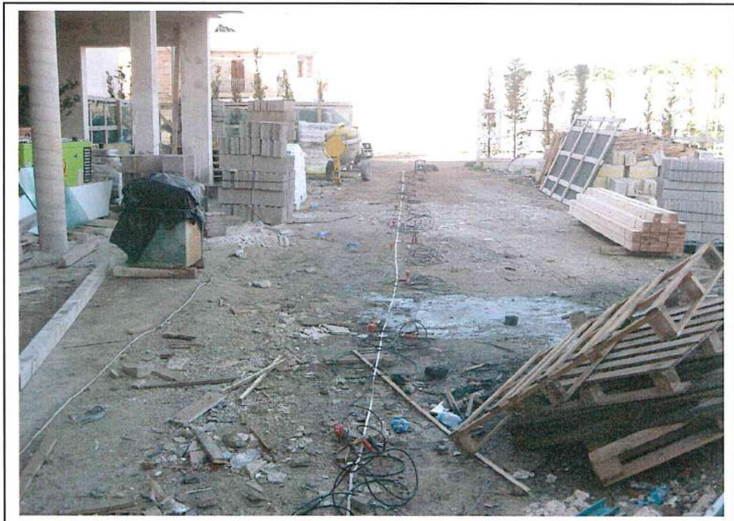
Esecuzione indagine sismica ReMi
