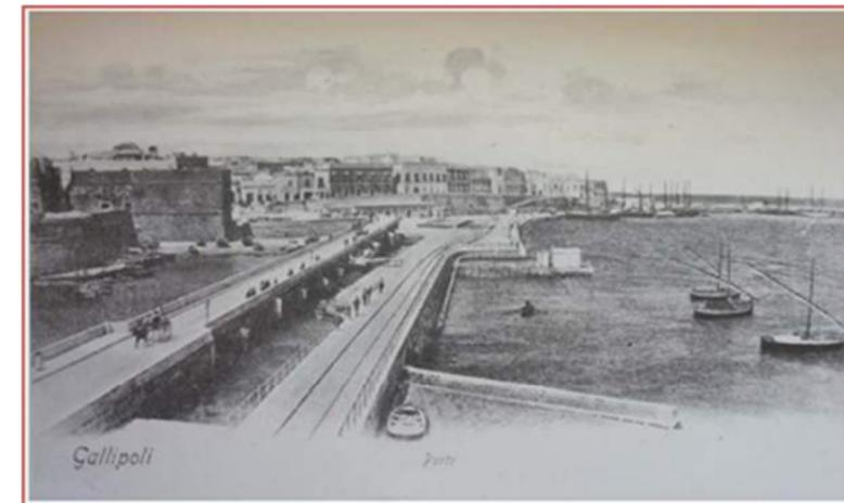
La struttura del ponte è composta da 7 archi a sesto ribassato (in parte sommersi) e tutti della stessa dimensioni, per una larghezza di 6.20 metri e altezza di metri 1.75. La lunghezza complessiva del ponte è pari a metri 154.72 ed ha una larghezza calpestabile di 8.75 metri. Il materiale lapideo utilizzato è tufo carparino squadrato connesso da malta, ora in stato di notevole degrado metrico.
