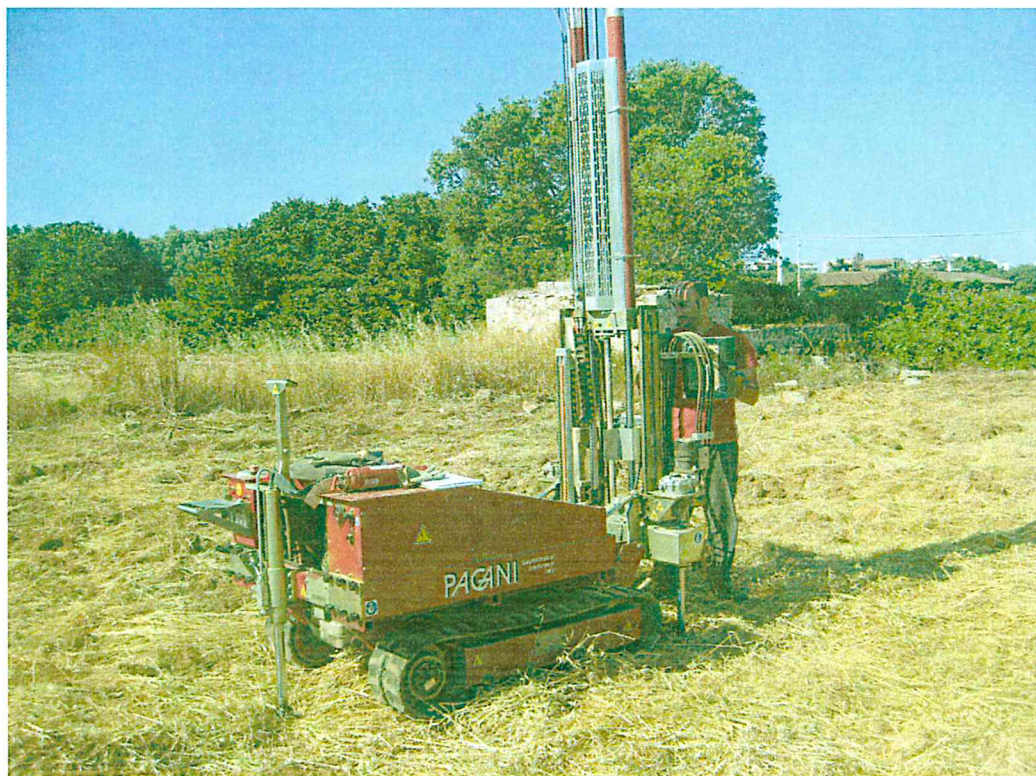
Esecuzione prova penetrometrica n.5
