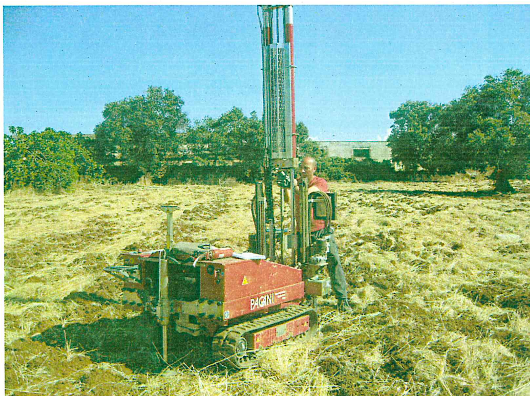
Esecuzione prova penetrometrica n.4
