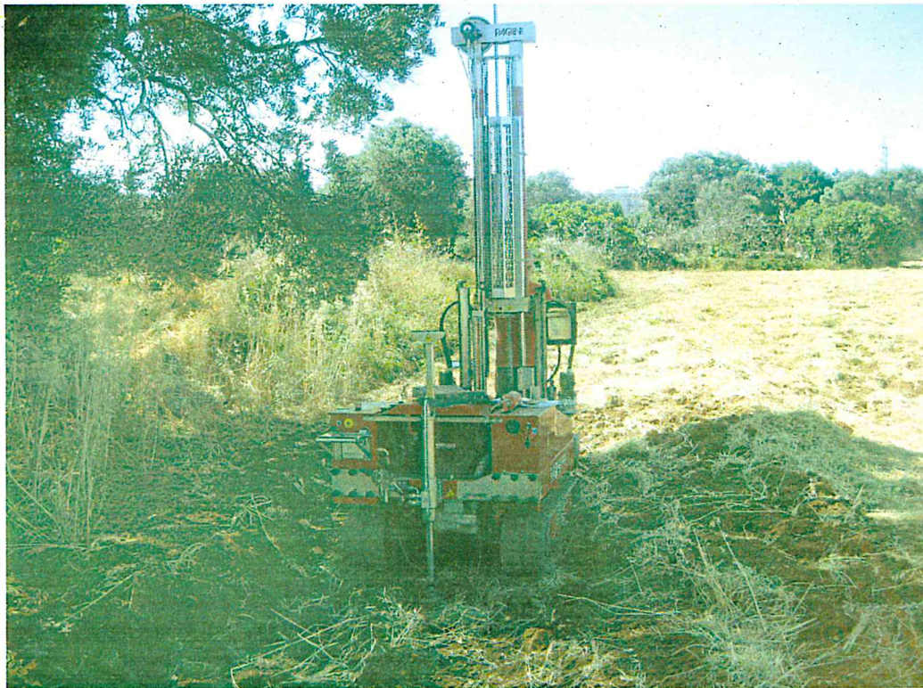
Esecuzione prova penetrometrica n.2
