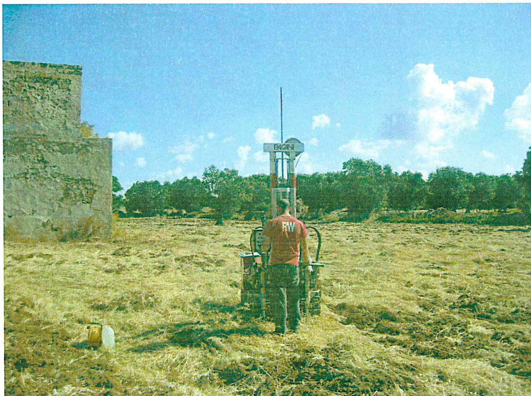
Esecuzione prova penetrometrica n.3
