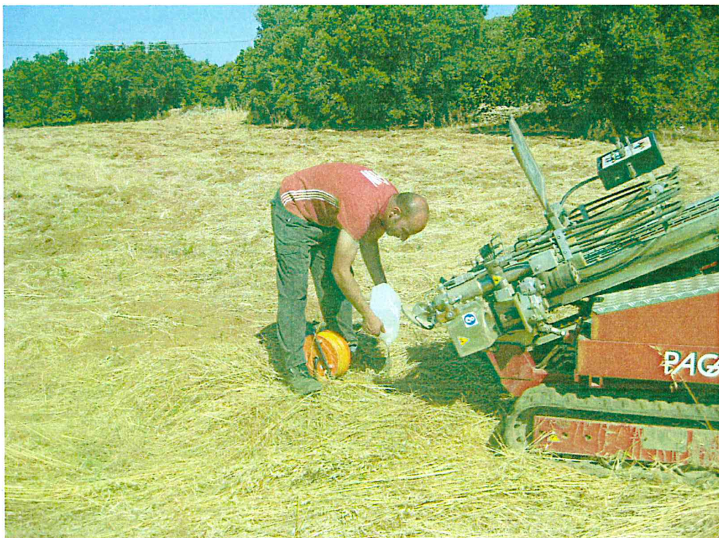
Esecuzione prova di permeabilità in foro n.3
