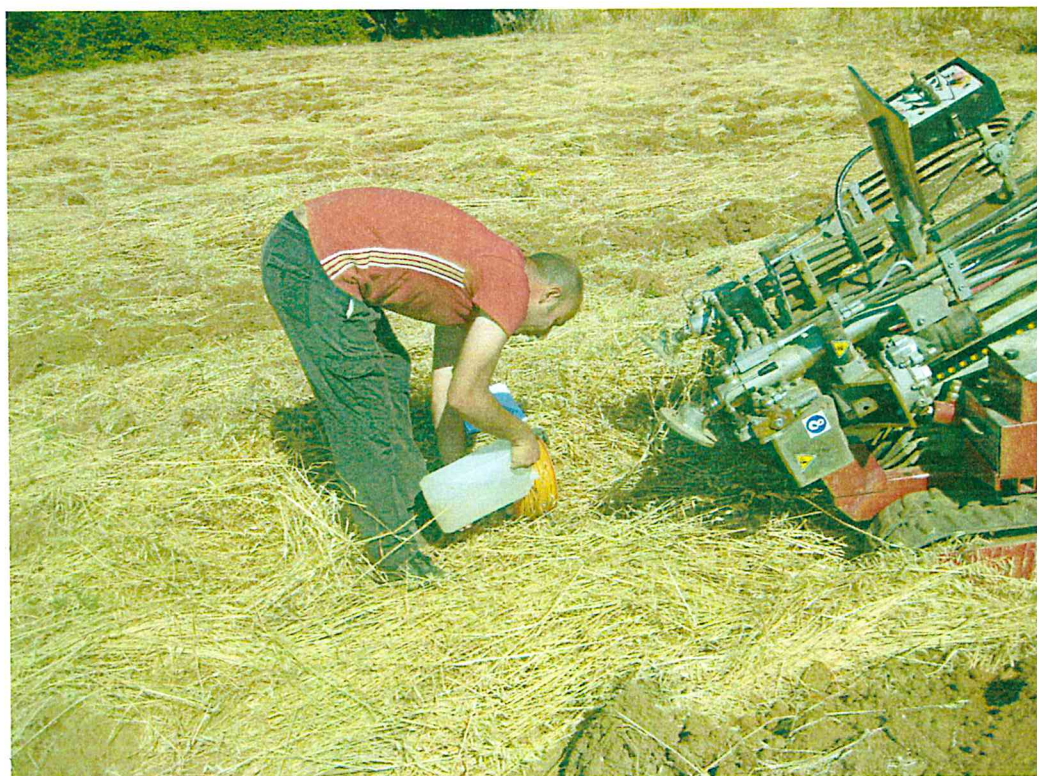
Esecuzione prova di permeabilità in foro n.1
