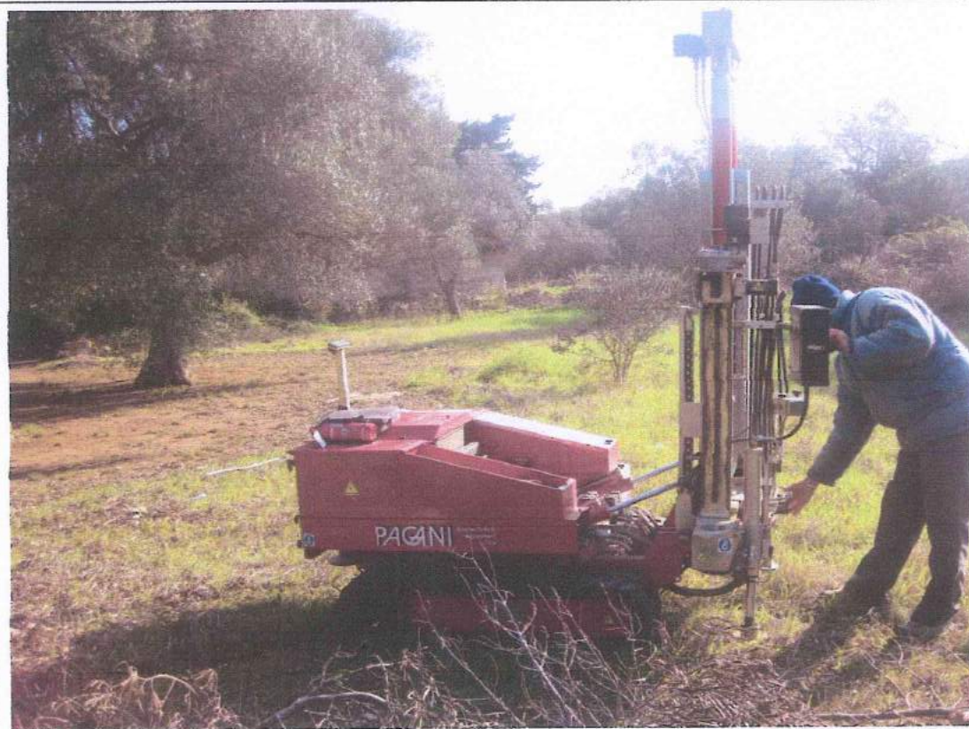
- Esecuzione prova penetrometrica n. 2
