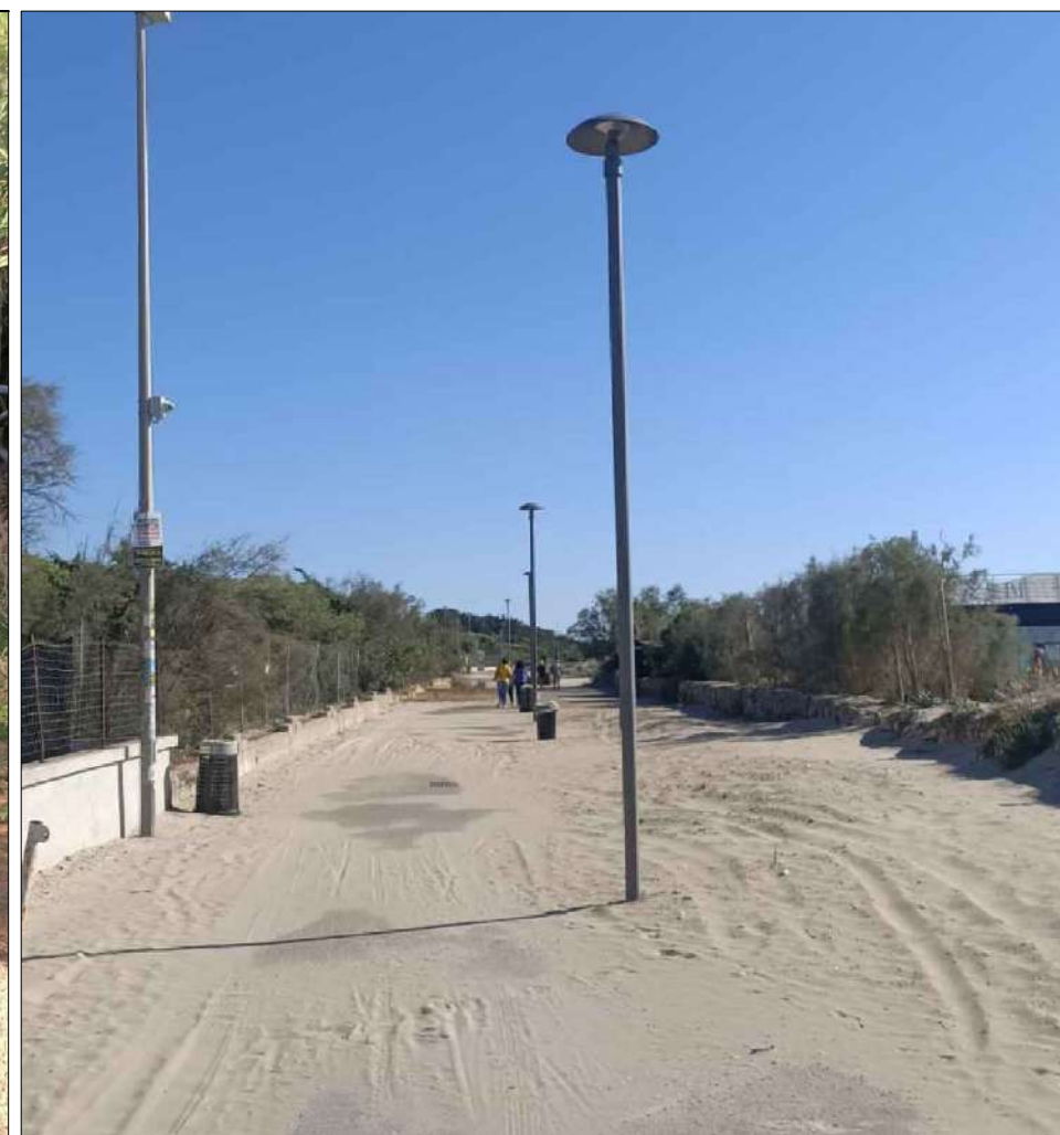
Ripresa fotografica n.2: percorso ciclopedonale esistente
