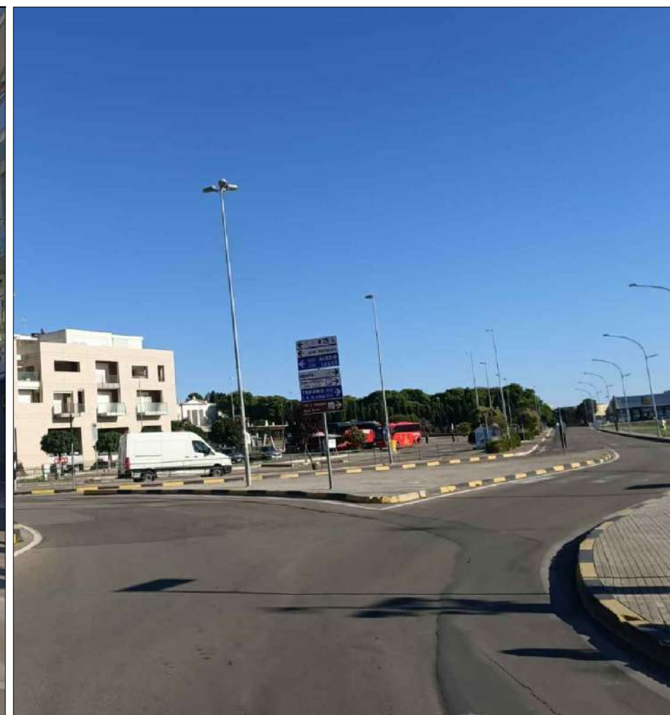
Ripresa fotografica n.2 : Tratto Corso Capo di Leuca-Parcheggio Via Zacà
