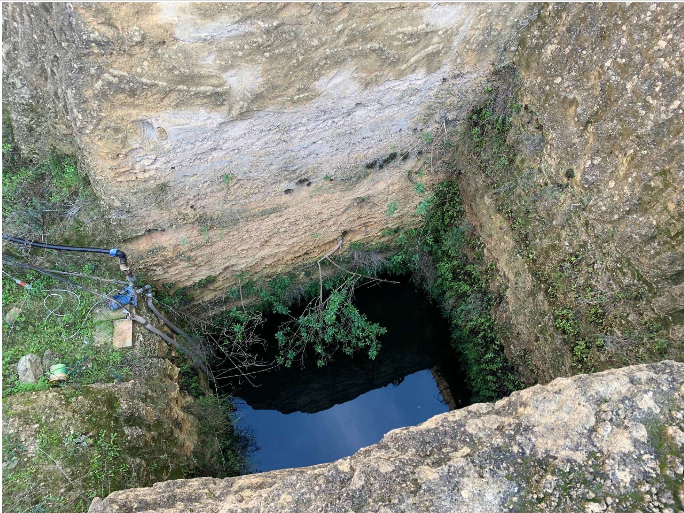
Foto 16 – Il vecchio pozzo di scavo presente nell'area retrostante del setto da abbattere per il suo colmamento.
