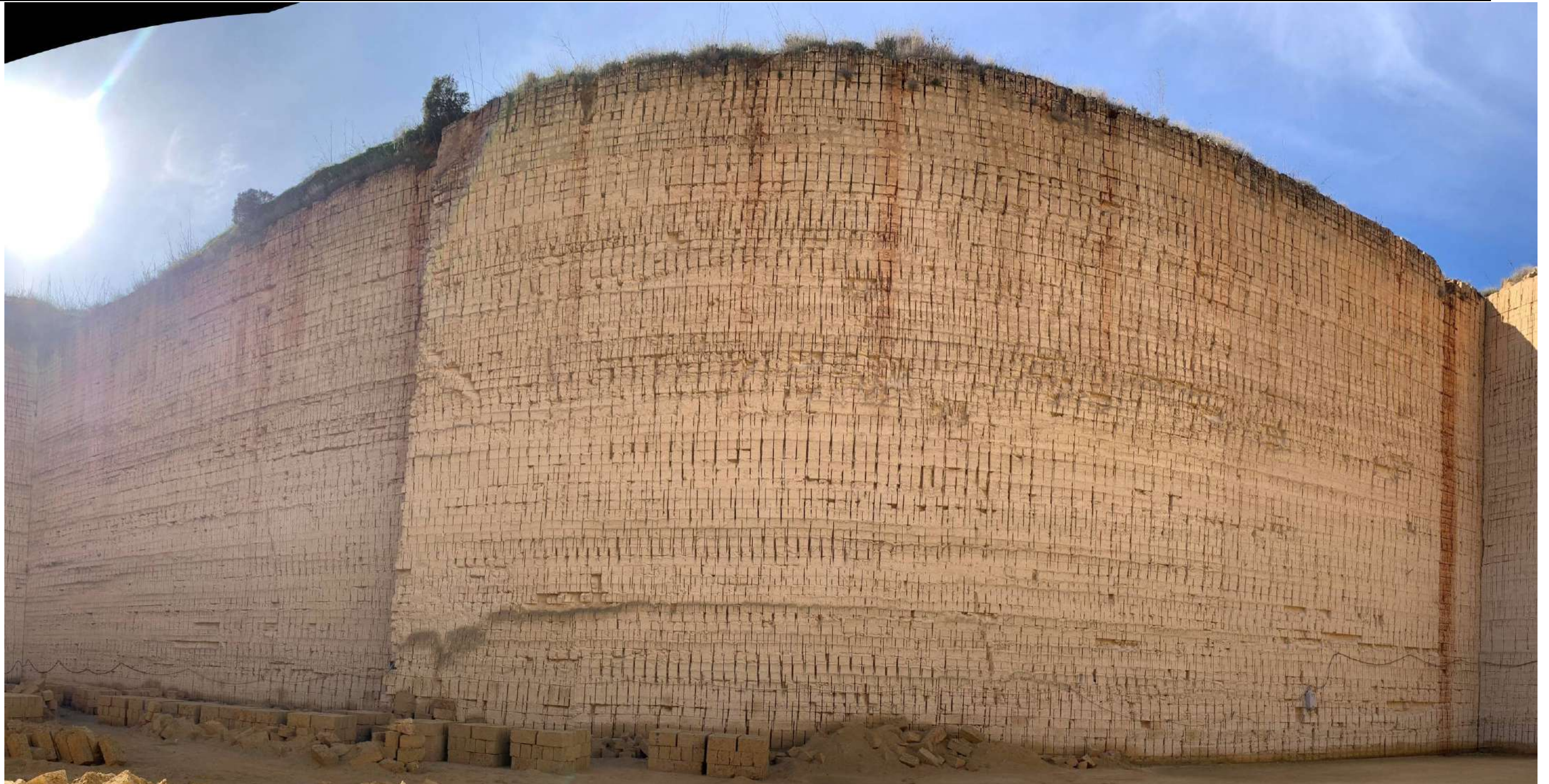
Foto 13 - Parete sud-ovest (meridionale): giacitura “apparente” sub-orizzontale, roccia sempre molto compatta con assenza di giunti di fratturazione.
