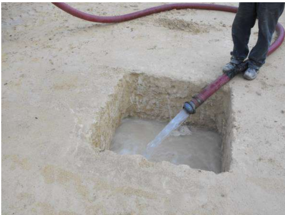
Riempimento del pozzetto P1
