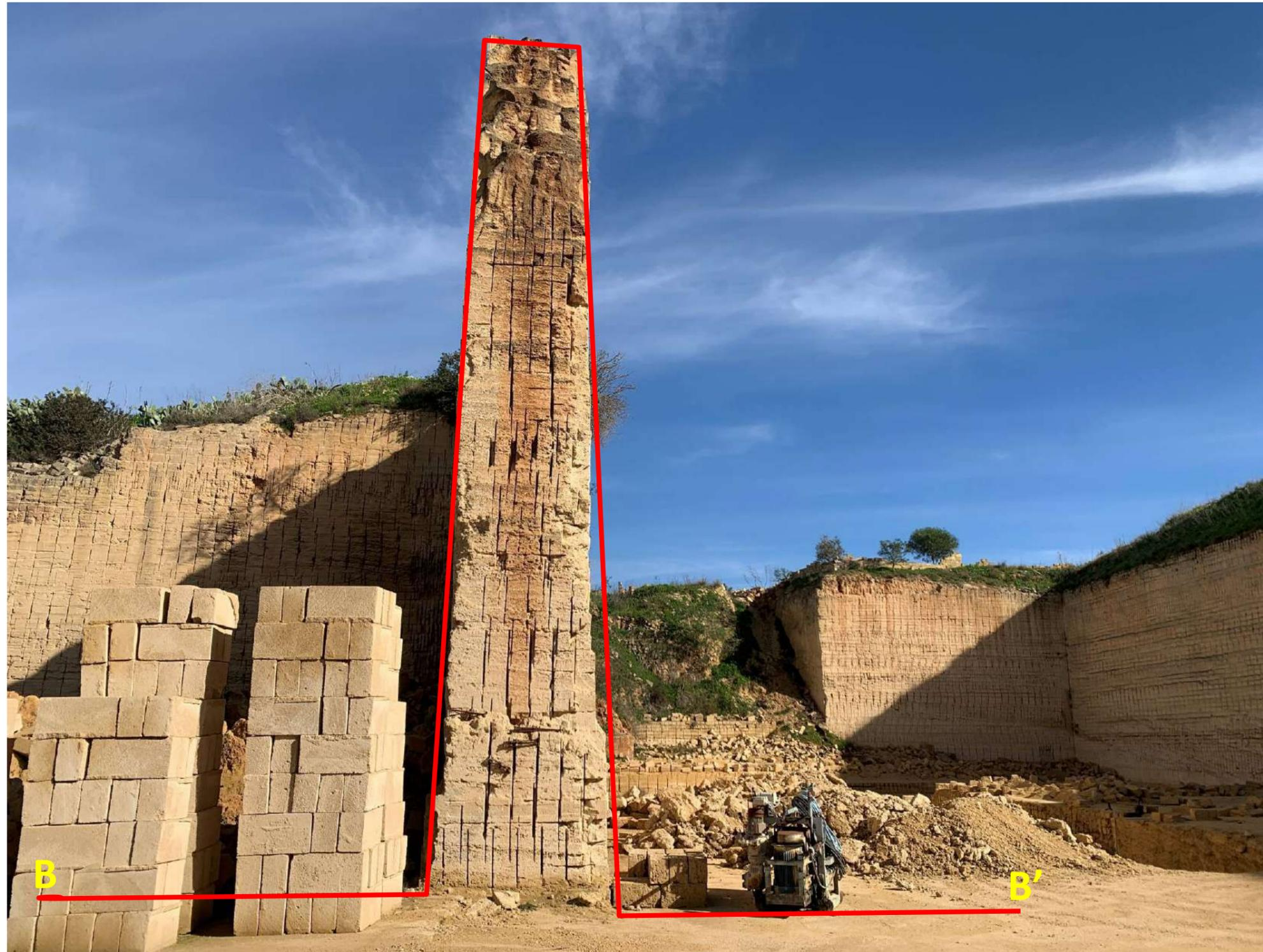
*Foto 24 - Ubicazione della sezione di verifica B-B' lungo il setto d'abbattere della parete nord del settore orientale del Sito 2. Per la sua conformazione (setto molto alto e sottile), risulta consigliabile l'esecuzione di specifica verifica di stabilità.*
